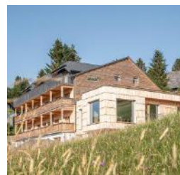
Todtnauberg: Zwölf hochwertig ausgestattete Apartments bieten Balkone mit Ausblick.
